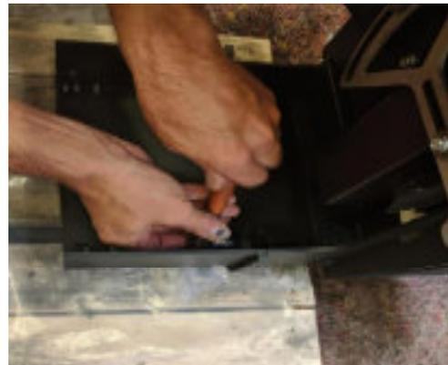
Positionnez les pieds du Range-bûche et utilisez les pieds de positionnement pour les fixer au corps du poêle. Utilisez une clé à molette ou une clé à douille pour les serrer à fond.
